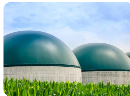
Impianto di biometano
